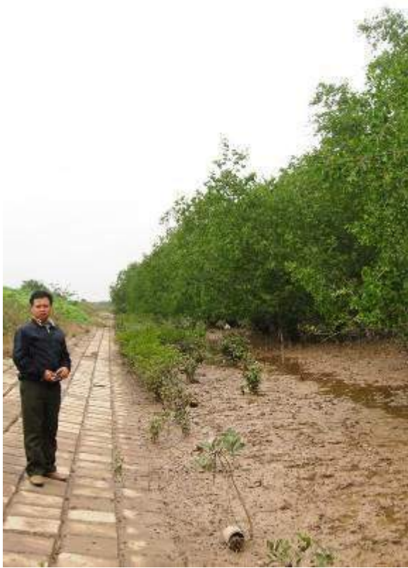
9 years old forest, 2 layers- to protect dyke in Tân Thành, Kinh Dương, HP
